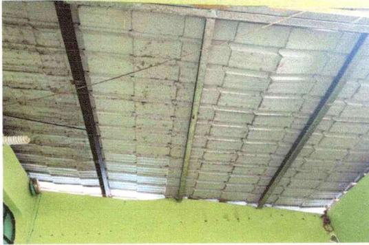
Foto 1: Cambio de techado por deterioro.
