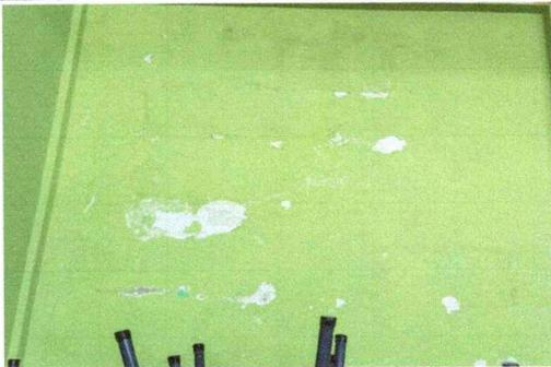
Foto 5: Cambio de pintura por deterioro.
